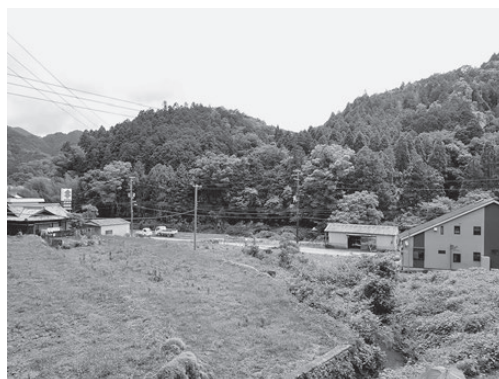
写真6 紀美野町釜滝の被災場所付近。2023年6月13日牛山撮影
