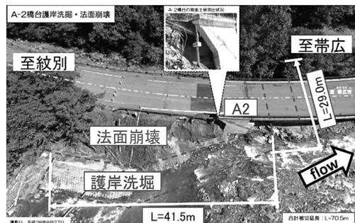
図5 A2橋台の被災<sup>1)</sup>
