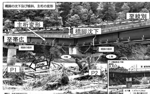
図4 被災後の高原大橋<sup>1)</sup>
