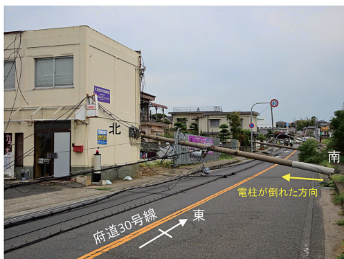
写真8 強風による電柱の倒壊状況 (2018年9月6日撮影, 大阪府泉南市新家)
