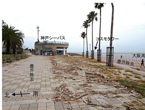
写真5 六甲アイランドのマリンパークにおける被害被害 (2018年9月6日撮影, 神戸市東灘区向洋町中)
