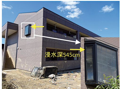
写真7 新築の賃貸住宅における浸水被害 (2018年7月31日撮影, 箭田)
