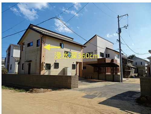
写真6 新興住宅地における浸水被害 (2018年7月20日撮影, 有井)
