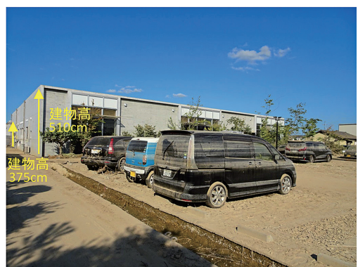
写真9 地域密着型特別養護老人ホームにおける浸水被害 (2018年7月20日撮影, 有井)
