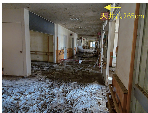
写真15 倉敷まきび支援学校における1階教室の浸水被害 (2018年7月31日撮影, 箭田)
