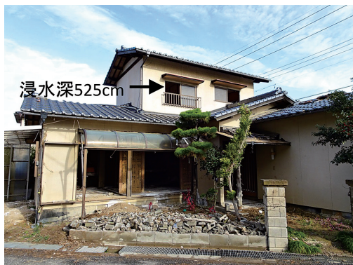
写真11 住家の浸水被害と2階の内部 (2018年12月5日撮影, 服部)
