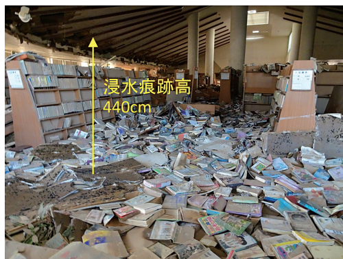
写真14 真備図書館における浸水被害 (2018年7月20日撮影, 箭田)
