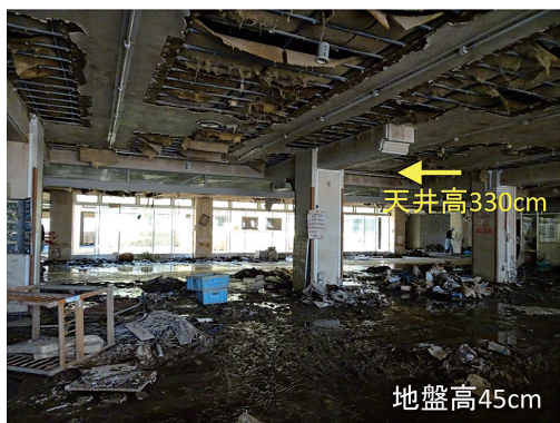
写真12 倉敷市真備支所の庁舎内における被害の状況 (2018年7月31日撮影, 箭田)
