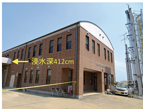
写真13 玉島消防署真備分署における浸水被害 (2018年7月20日撮影, 有井)
