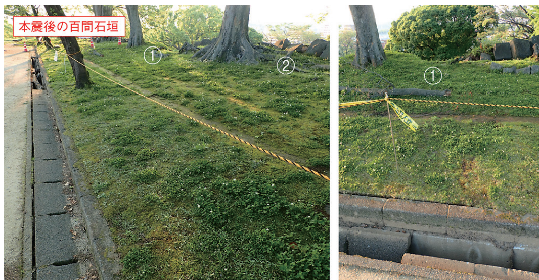
図9 百間石垣背面地盤の被災状況
