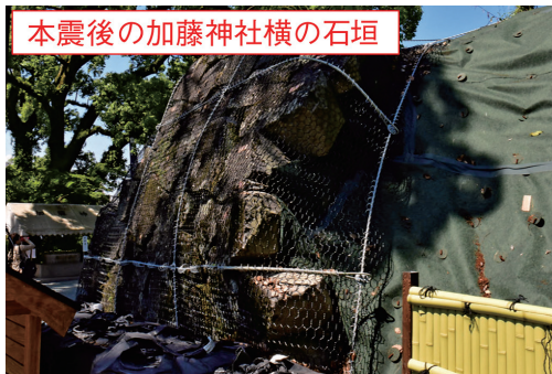
図6 加藤神社横の石垣の被災状況
