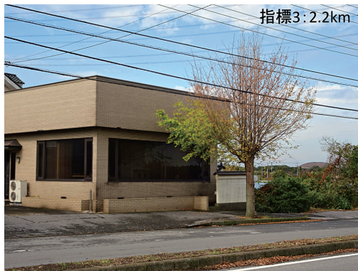
写真14 街路樹（イチョウ）における塩害の状況（富津市西川，2018年10月16日撮影）
