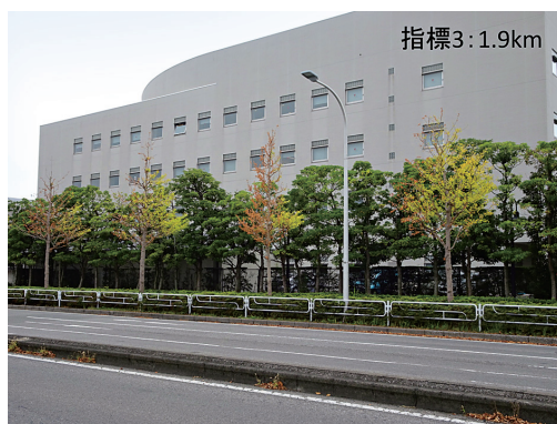
写真1 街路樹(イチョウ)における塩害の状況(千葉市美浜区若葉3, 2018年10月11日撮影)
