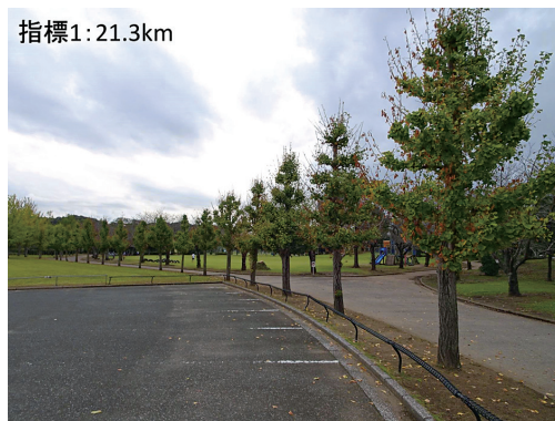
写真10 公園植栽(袖ヶ浦市百目木公園)における塩害の状況(袖ヶ浦市百目木, 2018年10月12日撮影)
