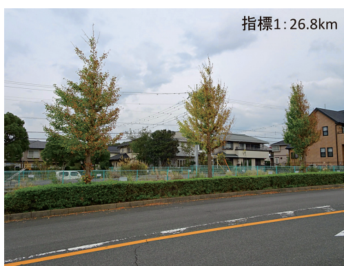
写真6 街路樹(イチョウ)における塩害の状況(我孫子市小林大門下, 2018年10月16日撮影)
