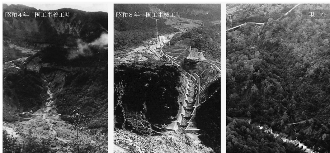
写真9-3-6 泥谷に於ける植生の復元状況 (国直轄工事着工時, 竣工時, 現在)
