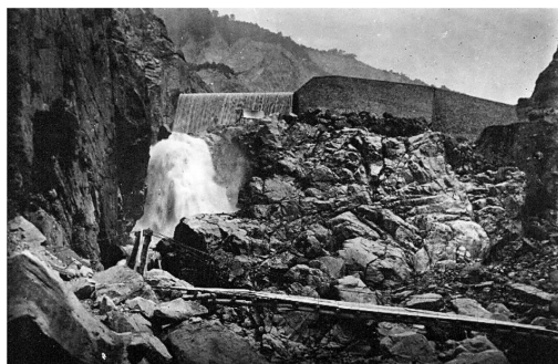
写真9-2-3 大正8年竣工の湯川第1号堰堤
