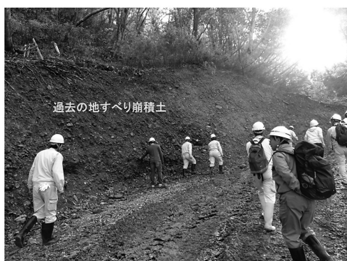
写真6-2 発生域境界部の東側斜面における状況
