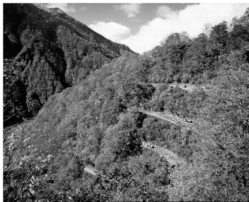
写真9-3-2 樺平の18段スイッチバック
