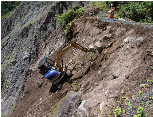
写真9-3-8 山腹工の法面整形（平成21年）
