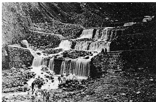
写真9-2-1 多枝原谷本流の練石積堰堤
