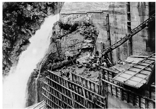
写真9-3-5 建設中の白岩砂防堰堤
