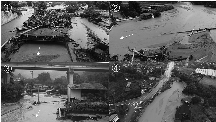
写真4 白木谷川の状況(①②大分自動車道北側，③大分自動車道南側，④前田橋の状況)
