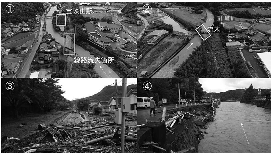
写真2 大肥川の状況 (①線路流失箇所, ②鉄橋に堆積する流木, ③宝珠山駅の状況, ④宝珠山駅前の大肥川左岸の状況)
