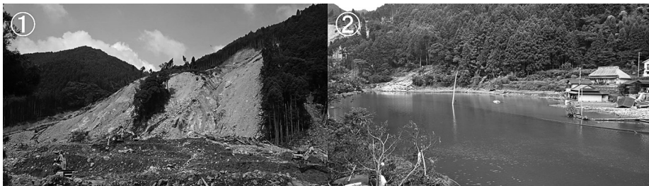
写真1 小野川上流の天然ダム (①崩壊斜面, ②ダム湖内の様子)
