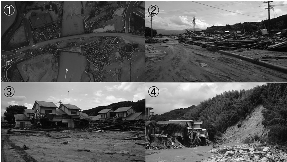
写真3 赤谷川の状況(①久保垣橋の流木堆積状況，②流木の堆積状況，③家屋の被害状況，④斜面崩壊箇所)
