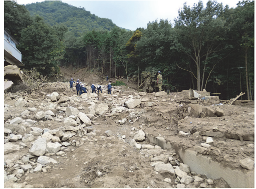
写真3 災害直後の図9中のA付近。2014年8月23日撮影。
