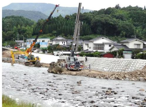
写真2 破堤した5k800左岸の修復作業（花月川）（2012年7月8日撮影）
