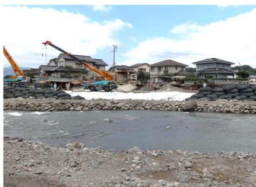
写真1 破堤した6k200右岸の修復作業（花月川）（2012年7月8日撮影）
