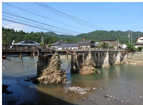
写真12 下郷橋における欄干の損傷と塵芥の痕跡（撮影日：2012年7月8日）
