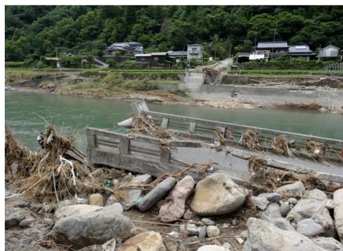
写真11 山国川の洪水による柳ヶ平橋の流失（撮影日：2012年7月8日）
