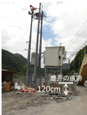
写真10 柿坂水位流量観測所 警報所のフェンスに見られる塵芥の痕跡と水圧による損傷（撮影日：2012年7月8日）
