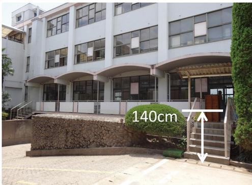
写真3 昭和学園高等学校の浸水被害(浸水深: 140cm, 撮影日: 2012年7月8日)
