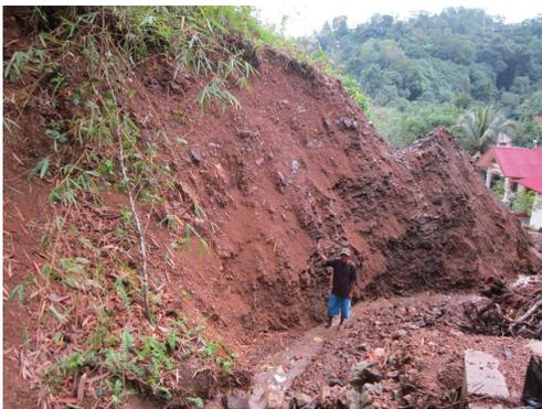
写真5 道路を切断した地すべり（人が立っている地点が旧道）（バツメラーにて2012. 7. 13撮影）
