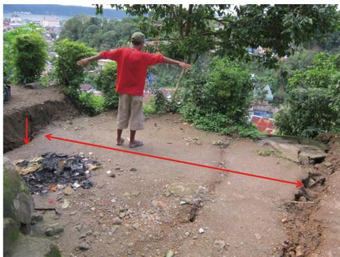
写真1 地震によって尾根部に発生した地盤のクラックと陥没の状況（バツガジャーにて2012.7.13撮影）
