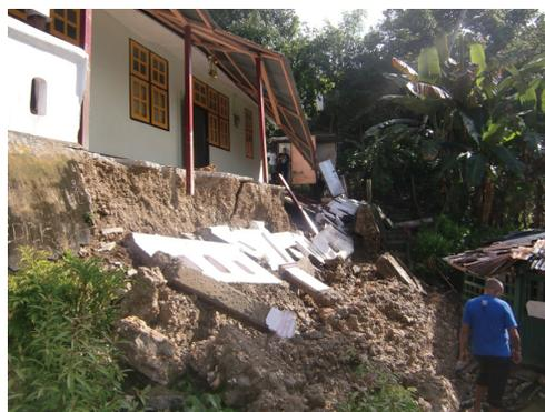
写真4 上位の建物破壊が下位の建物破壊に波及 (バツガジャーにて2012. 8. 2撮影)
