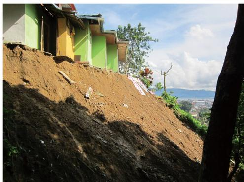
写真2 尾根部に建つ学校の基礎部破損状況 (バツガジャーにて2012. 7. 13撮影)
