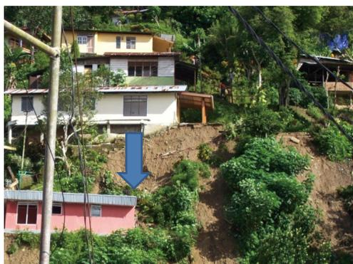
写真3 (a) 急斜面で発生した地すべりによる住家被害 (バツガジャーにて2012. 7. 13撮影)
