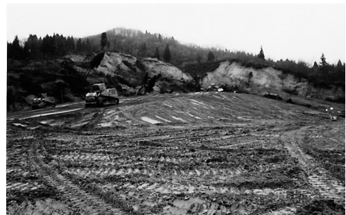
写真4.12 東竹沢地すべり頭部土塊の切土施工(2004/11/27撮影)
