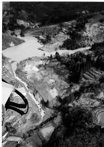
写真 4.9 東竹沢天然ダム緊急排水路における異常浸食 (2004/11/17撮影)
