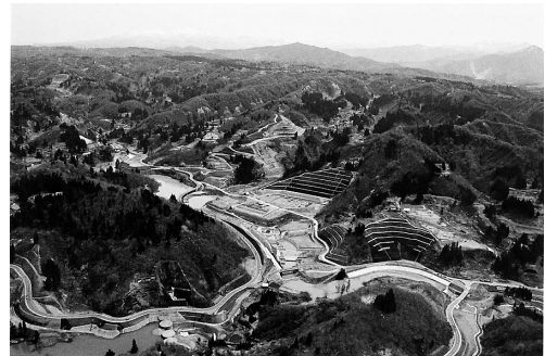
写真4.13 東竹沢天然ダム恒久対策工事概成状況(中越地震後2年半経過後)
