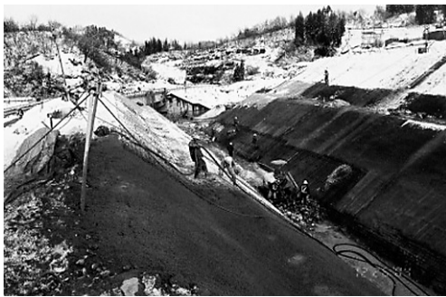
写真4.11 融雪出水にも対応可能な断面を有する仮排水路(2004/12/26撮影)
