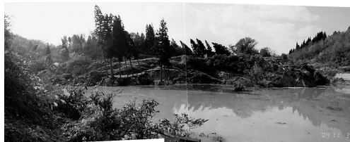
写真4.5 前沢川より見た東竹沢地すべり末端部の状況(地すべり土塊の中央部では樹木が直立。末端部ではすべり面の切れ上がりに対応し樹木が連続的に山側に傾斜。2004/11/03撮影)
