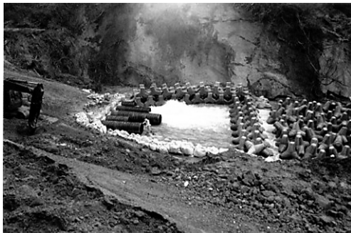
写真4.10 追加施設としての埋設管路による代替水路(2004/12/08撮影)
