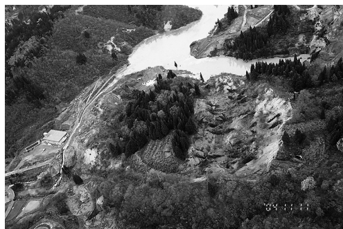
写真 4.8 東竹沢地区天然ダムにおける緊急排水状況 (2004/11/11撮影)
