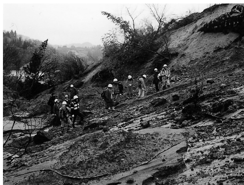
写真4.3 主滑落崖で確認されたすべり面 (2004/11/16撮影)
