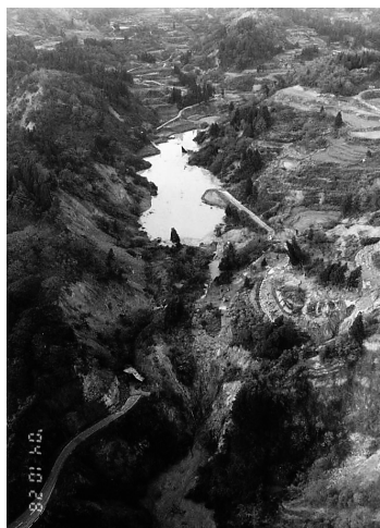
写真4.6 寺野天然ダムによる芋川閉塞部 (2004/10/28撮影)
