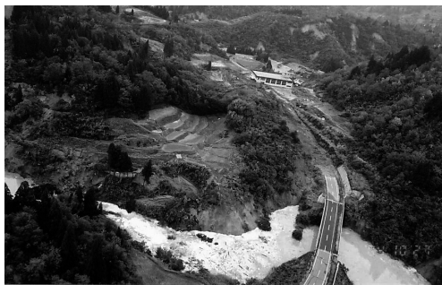
写真4.2 東竹沢天然ダムによる芋川閉塞部 (2004/10/27撮影)
