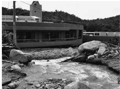
写真2 土石流の直撃を免れたライフケア高砂の2階部分（防府市真尾，2009年7月25日撮影）
