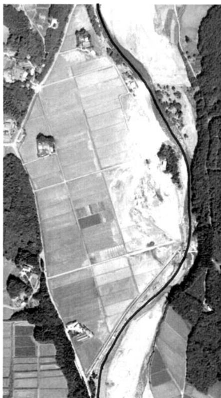
写真8 協和橋の下流側の湾曲部の被災状況（上が上流）
