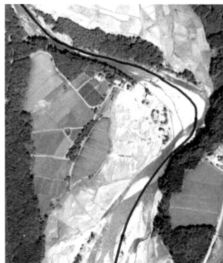
写真7 法師畑の上流側の湾曲部の被災状況 (上が上流)
