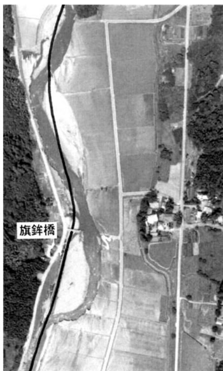
写真6 黒川の旗鉾橋上下流の被災状況 (上が上流)
