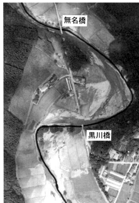
写真4 黒川の追田原地区の被災状況(上が上流)
