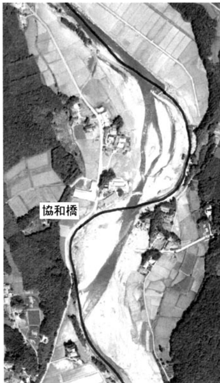
写真3 余笹川の砂の目地区の被災状況(上が上流)
