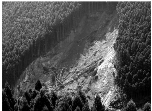
写真2 滑落した地すべりのクローズアップ (諏訪 浩 2004.8.14 撮影)
