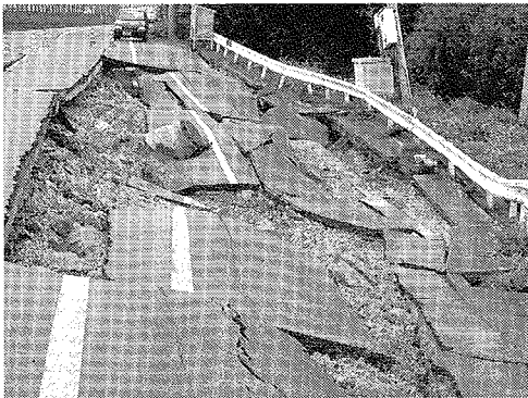
写真3 道路の被害例
