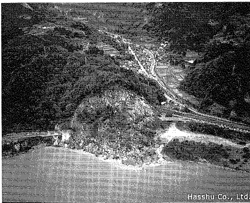
写真 10 白岩の崩壊現場 12)
