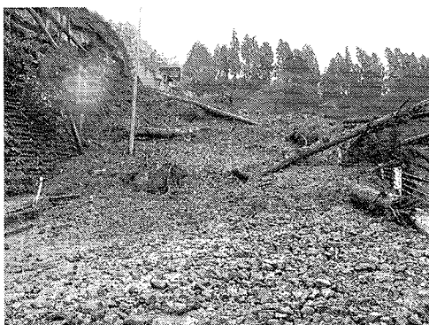
写真6 国道291号線東山トンネル出口付近の崩壊土砂
