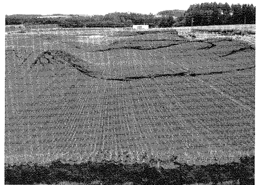
写真 5-3 クッチャロ軽石流堆積物の盛土の大規模流 動崩壊（2003年十勝沖地震：端野町 農地）
