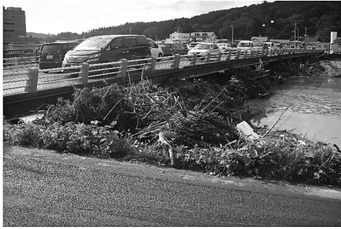
久慈川・上の橋 (a) に掛かる流木 (久慈市消防課)
