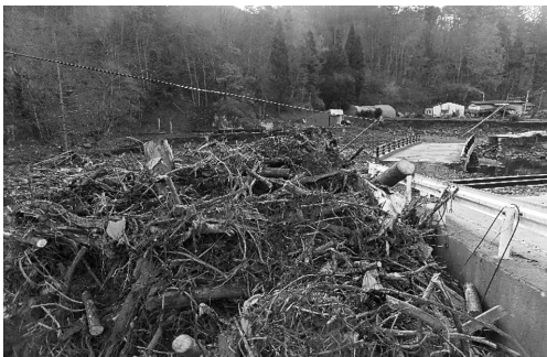
(b) 長内川山根町下戸鎮の橋梁の損壊と流木状況:筆者撮影
