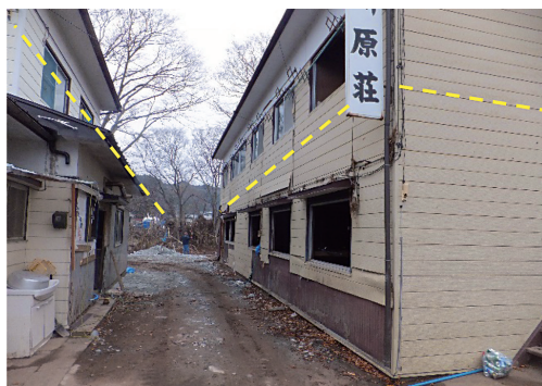
(b) 清水川・小本川合流付近の浸水アパート
