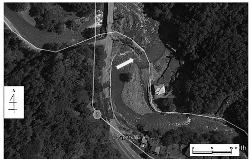
(c) 長内川山根町下戸鎮の橋桁の損壊と流亡(2016.9.1洪水翌日)
