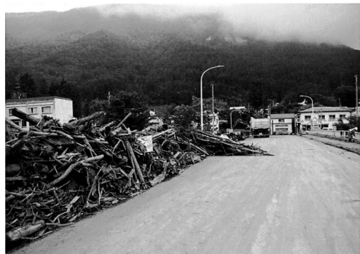
(b) 小本川・岩泉橋に集積した流木 (岩手県)
