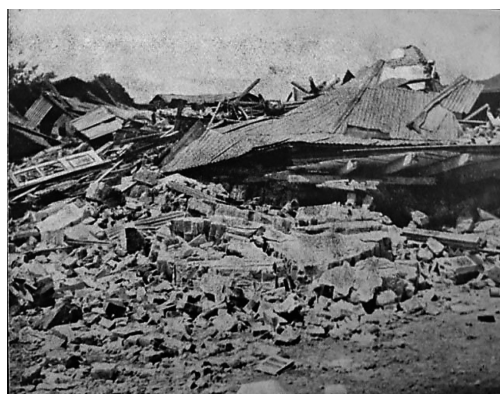
写真3 1926年パダン地震によるパダン・パンジャンの石造建築倒壊の様子
