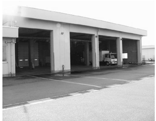
写真4 救援物資臨時保管場所（消防車用駐車場）
