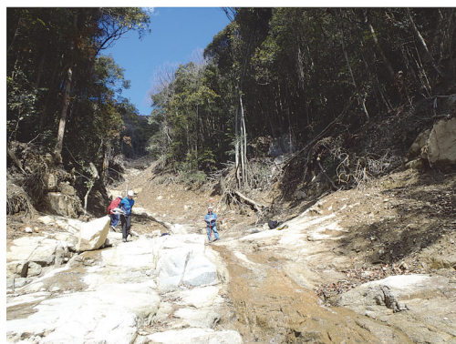
写真1 断面IIIの全体像(下流より上流を望む)
