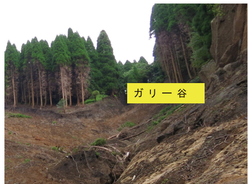
写真2-3 ガリー浸食による表層崩壊
