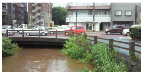
写真5-2 熊本市の白川子飼橋南詰付近の水路の様子（2012年7月12日午前9時ごろ）岡田撮影 まちはあたかも何事が起こりつつある事を知らぬかのように動いている
