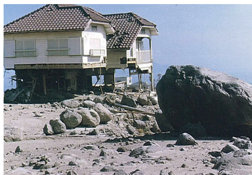
写真2.2 土石流による被害 (国道57号付近) 1991年6月30日
