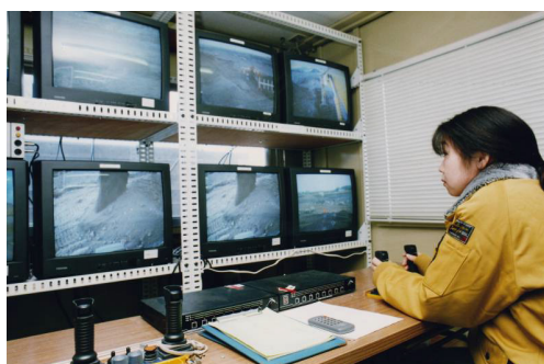
写真2.8 無人化施工機械の操作状況
