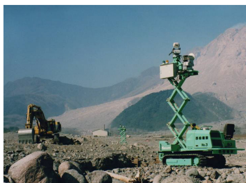
写真2.7 無人化施工状況
