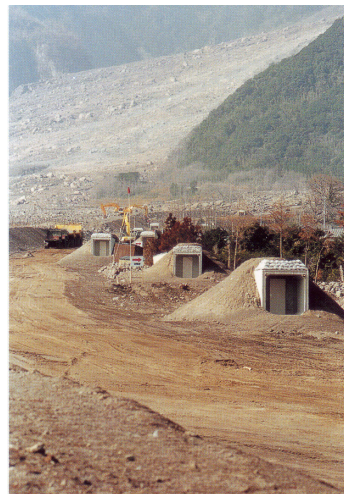
写真2.6 避難シェルター
