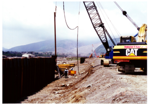
写真2.5 警戒区域内の矢板設置工事の状況
