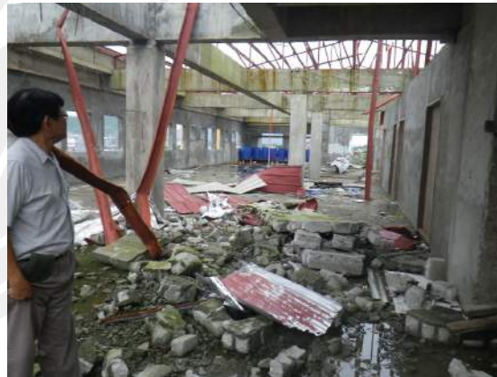
被災した病院
