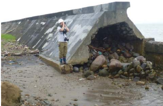
海岸堤防の被災状況調査
